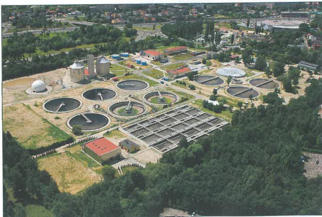
Fot. 1. Oczyszczalnia Ścieków Klimzowiec
