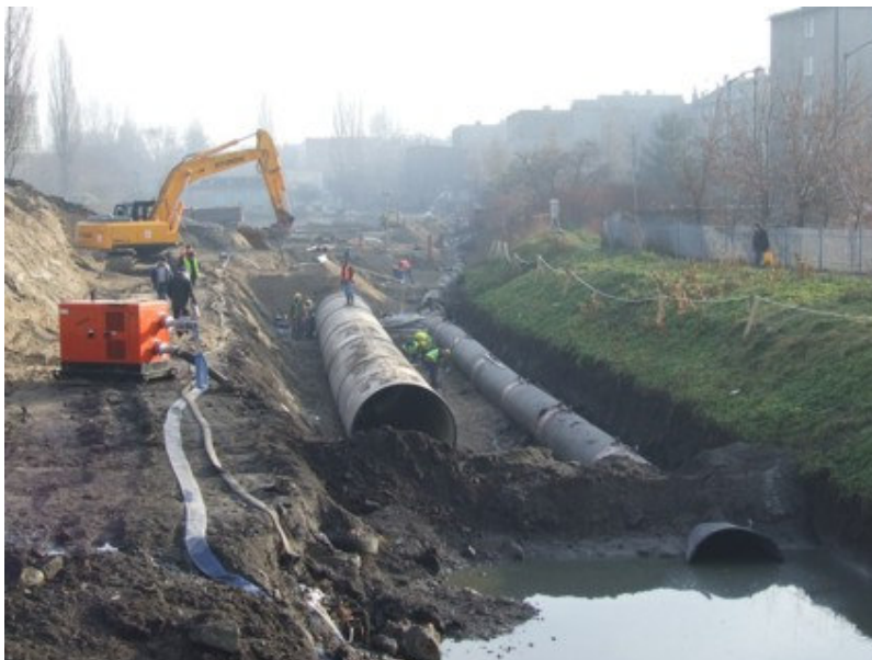
Odcinek Rawy przy ul. Dąbrowskiego, w trakcie przykrywania (listopad 2008 r.)
