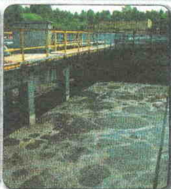
Koszt modernizacji oczyszczalni ścieków Klimzowiec szacuje się na 100 mln zł
