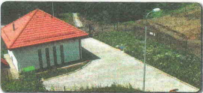
Z początkiem roku w Świętochłowicach oddano do użytku przepompownię ścieków
