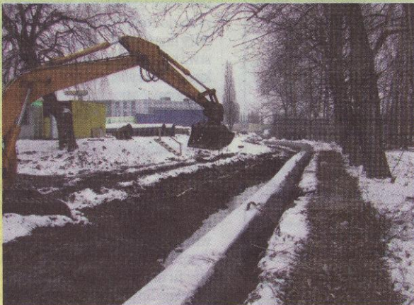
Prace przy ul. Trzynieckiej
