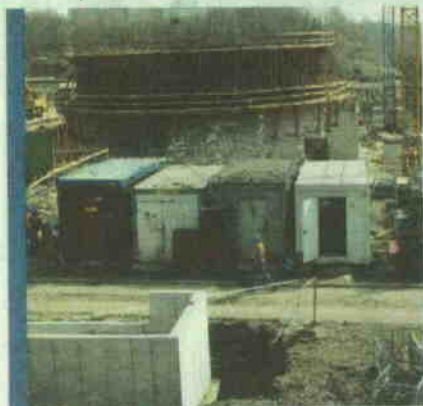
Trwa budowa zbiorników do fermentacji osadu czynnego. Pomiędzy wykonaniem obydwu zdjęć minęło 20 dni.
