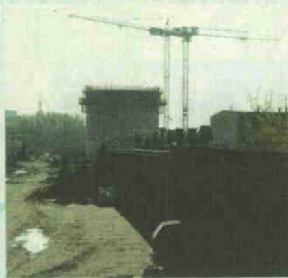
Trwa budowa zbiorników do fermentacji osadu czynnego. Pomiędzy wykonaniem obydwu zdjęć minęło 20 dni.
