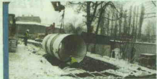
Taka sytuacja już nigdy nie będzie miała miejsca. Teraz w miejscu, gdzie Rawa wystąpiła z brzegów, zamiast otwartego koryta Rawy jest wygodny deptak skrywający w sobie ogromne rury.
