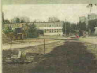
Modernizacja kanalizacji w Chropaczowie
