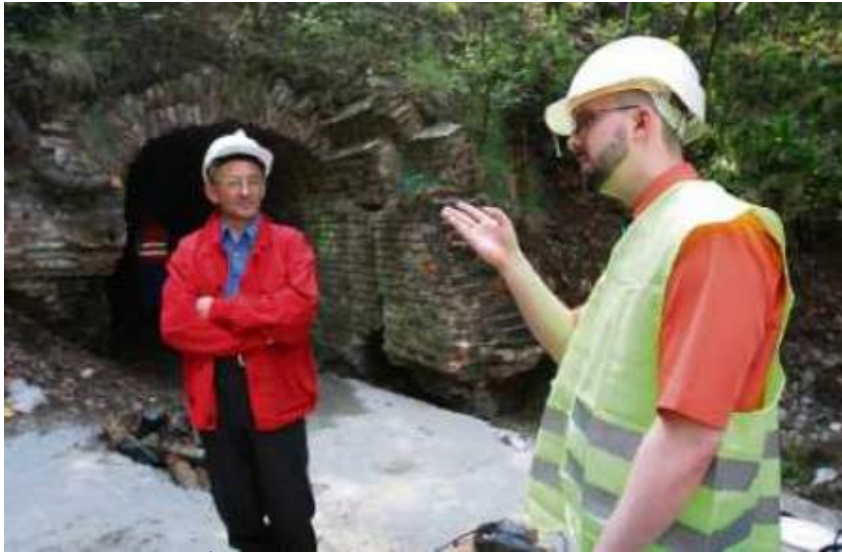
Bartłomiej Jarocho z ChŚPWik oraz Stanisław Kowalski (od prawej) z firmy Energoterm przy wylocie kanału pokopalnianego w Chropaczowie. W tym miejscu stanie przepompownia. Pierwsze prace już się tu rozpoczęły.
